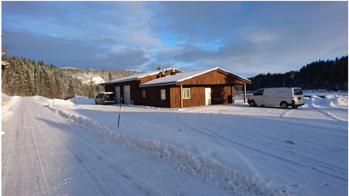
Det nye kloakkrenseanlegget på Trofors 09.03.2021
